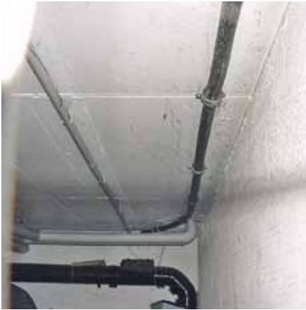
Bild 5: Elektrische Hausanschlussleitung an der Außenseite des Wohnzimmers.
