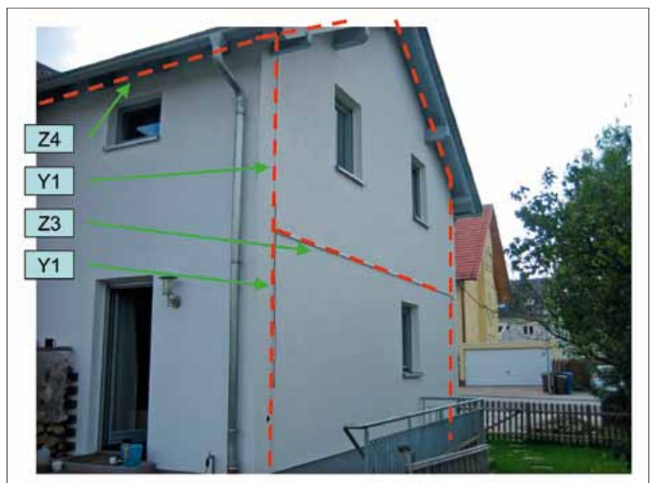
Bild 13: Lage der Kompensationsschleifen in der Hausfassade.
