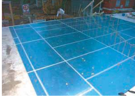
Bild 12: Verlegung von „Sandwich“-Abschirmblechen im Fußbodenbereich über einer 10-kV-Erdleitung.
